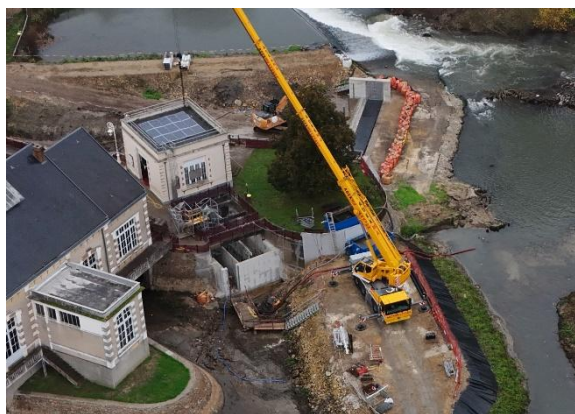
Création d'une passe à poissons au barrage de l'Epau
